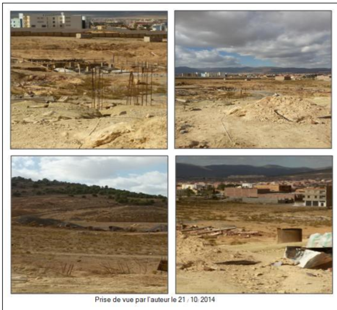
Photo VII-28 : Le site devant accueillir le lycée est empiété par des fondations en cours de réalisation d'une promotion immobilière privée
