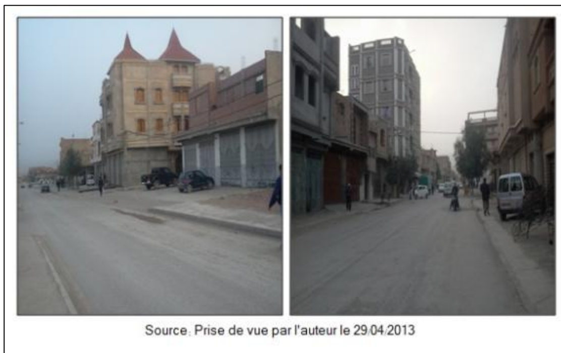
Photo VII-2 : Constructions de types « grande maison » sur le boulevard principale, créant ainsi un hétéroclite du paysage urbain et d'autres constructions en cours
