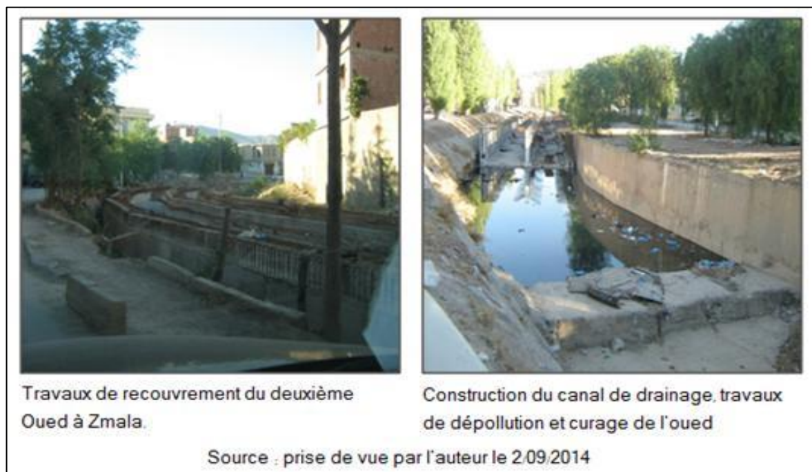
Photo VI-7 : Travaux de recouvrements des oueds qui traversent la ville de Batna
