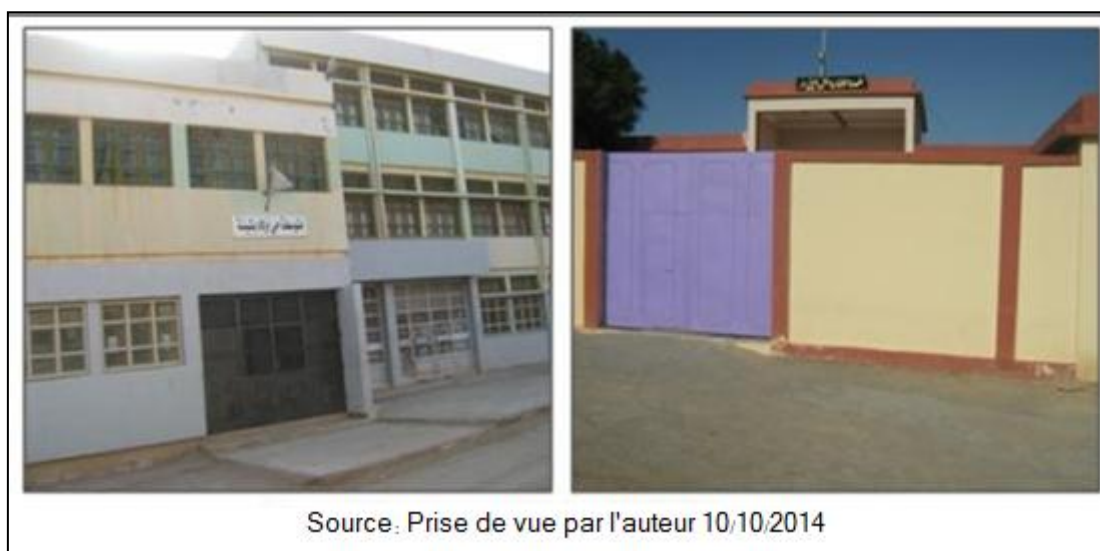
Photo VII-13 : Équipements réalisés : une école primaire et un CEM.
