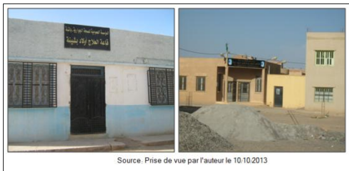
Photo VII-5 : Centre de santé de proximité un type d'équipements existants
