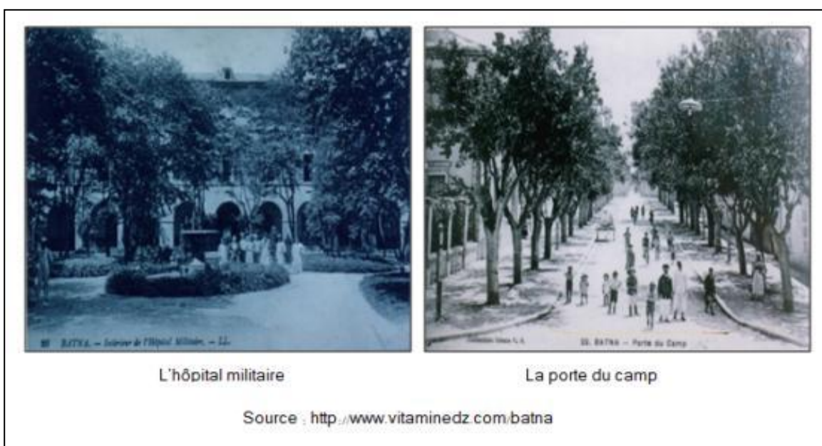
Photo II-5 : les édifices de la colonisation
