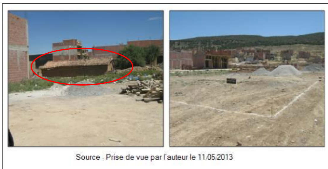
Photo VII-22 : À gauche une construction très ancienne complètement délabrée À droite un exemple de parcelle de terrain à vendre tracée pour bien la délimiter
