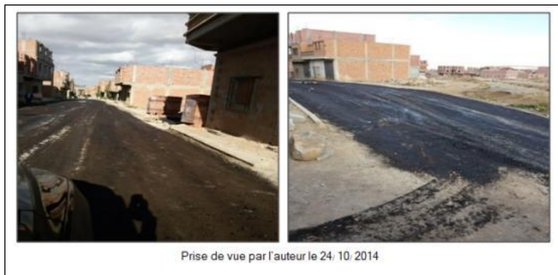
Photo VII-24 : Des voies tertiaires fraîchement bitumées
