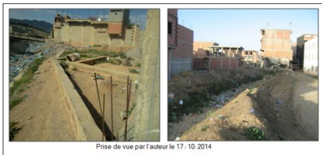
Photo II-21 : Construction interdite et dangereuse au bord de l'Oued
